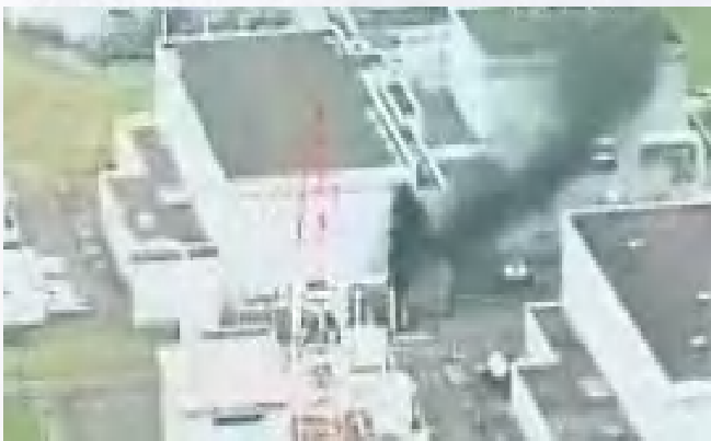
写真1 3号機変圧器の火事の航空写真
